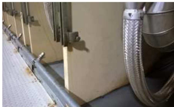
Equipamentos depois da aplicação do produto
